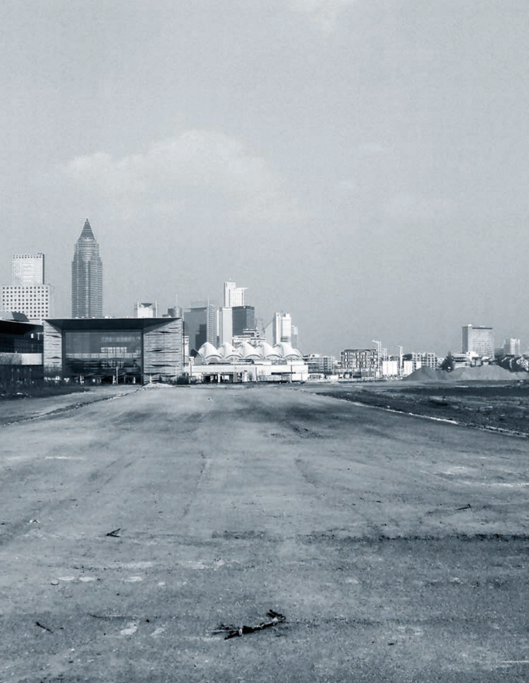
Das geräumte Grundstück für die Wohnprojektentwicklung Parkend: 46.215 Quadratmeter groß, westlich der Messe Frankfurt gelegen.
